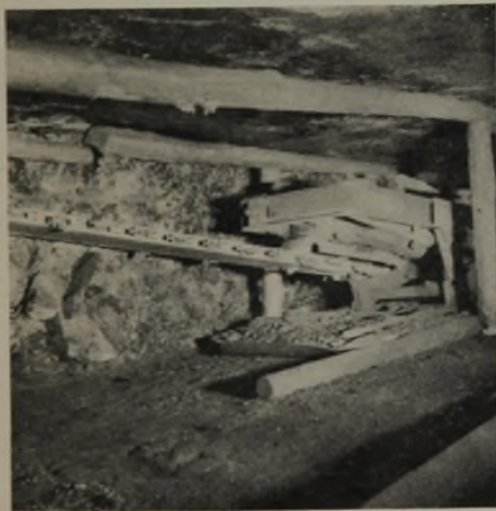
Abb. 1. Schrägkerbmaschine der Firma Eickhoff in Arbeitsstellung.
