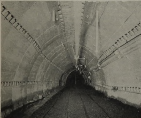
Abb. 9. Übliches Querschlagprofil von 11,47 m 2 .
