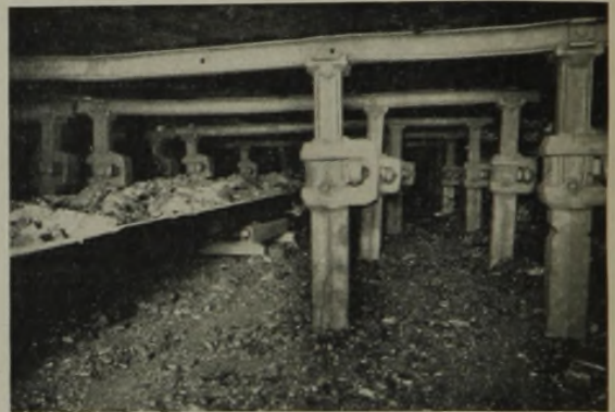
Abb. 5. Das Fahrfeld an der Kohlenstoßseite.
