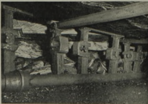
Abb. 4. Die Reihenstempel an der Bruchkante.
