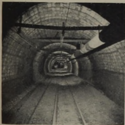
Abb. 1. Betonformstein-Ausbau aus Einsteinform mit Quetschholzeinlagen.
