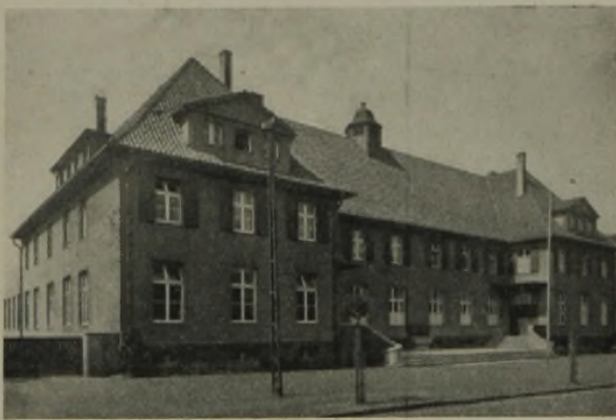
Werksfürsorgegebäude einer Ruhrzeche.
