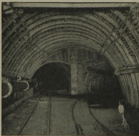
Abb. 13. Zeche Recklinghausen, Streckenabzweig auf der 3. Sohle, Richtstrecke zum Wetterschacht Recklinghausen-Ost. Bögen vor dem Abzweig Profil 21 kg/m, Nutzquerschnitt steigend von 12–25 m 2 ; Bögen nach dem Abzweig Profil 14 kg/m, Type C, Kurvenradius 30 m.
