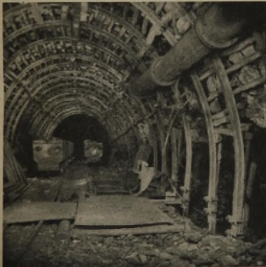
Abb. 8. Zeche Julia, Flöz Dickebank, 6. Sohle, 9. Gesenk, Ort 5 Westen. Streckenbogen Profil 14 kg/m, Type C mit verlängertem Stempel.
