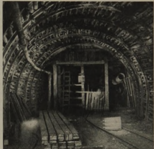
Abb. 11. Zeche Julia, Füllort des 12. Blindschachtes, 5. Sohle, nach dem Umbau mit Streckenbogen Profil 21 kg/m, Type F.
