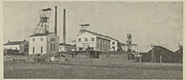
Abb. 9. Die Kolombusschächte bei Maltheuern.
