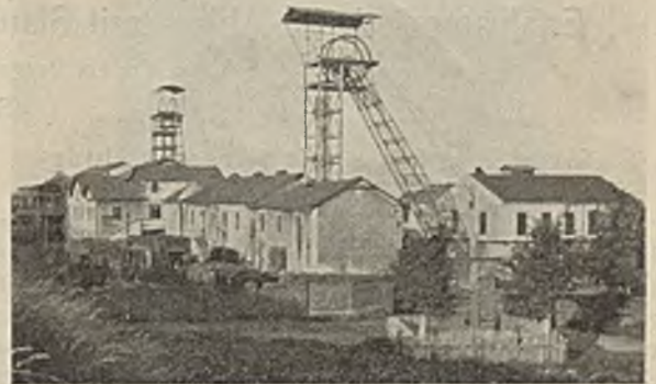
Abb. 16. Schacht Nelson 3 bei Osseg.
