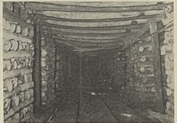
Abb. 3a. Unter nicht besonders starkem Druck stehende Strecke in 600 m Teufe.
