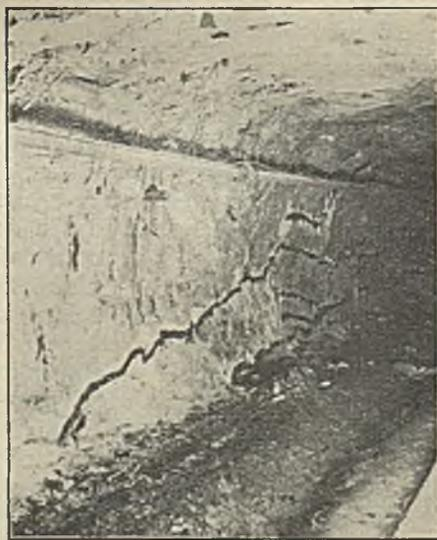
Abb. 14. Spalten im Anhydrit über dem Abbau der 8. Sohlenstrecke (Profil A—B in Abb. 13).
