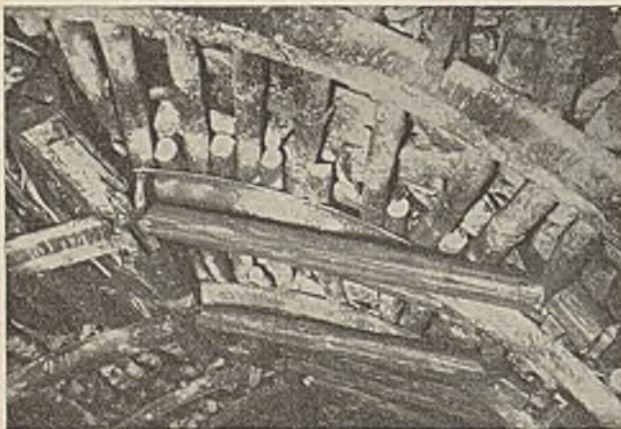
Abb. 7. Einseitige Schubwirkung in einer Abbaustrecke.
