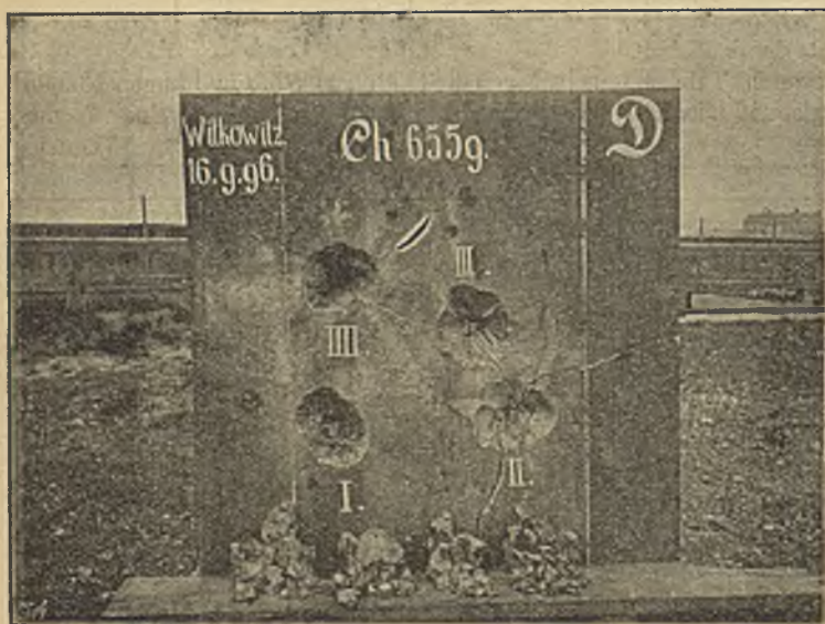
Abbild. 2. Vorderseite der Platte Ch 6559 nach dem Schufs.
