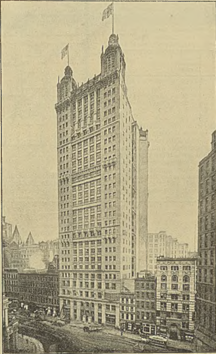
Abbild. 1. Das Park Row-Gebäude in New York.
