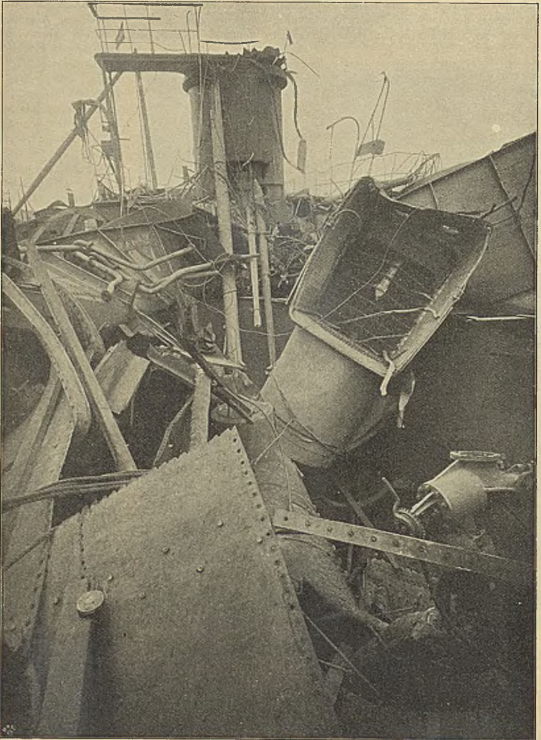
Figur 7. Beschädigung eines türkischen Torpedobootsjägers infolge einer Kesselexplosion.
