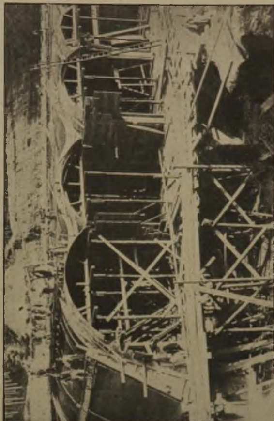
Abbildung 10. Betonierung der Gewölbe und Widerlager. Dycerhoff & Widmann A.-G., Niederlassung Nürnberg.
