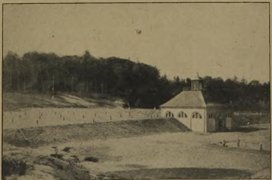
Abbildung 16. Blick auf den überschütteten Hochbehälter und das Schieberhaus.
