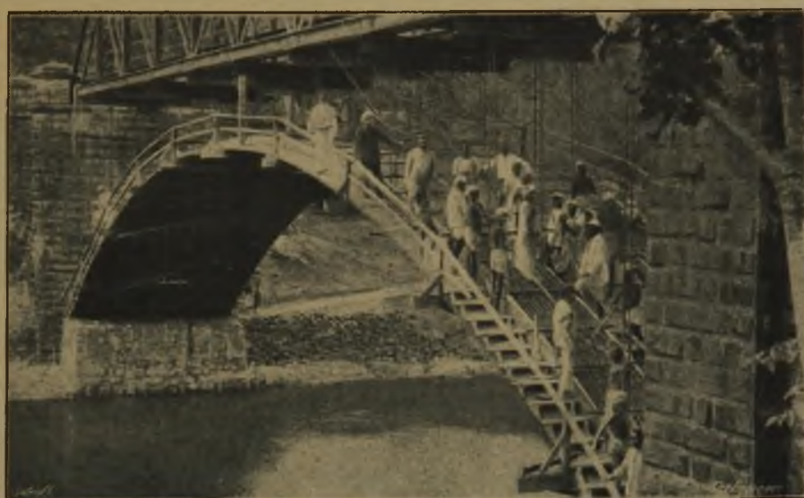
Abbildung 5. Ausführung der Eisenbeton-Lehre.
