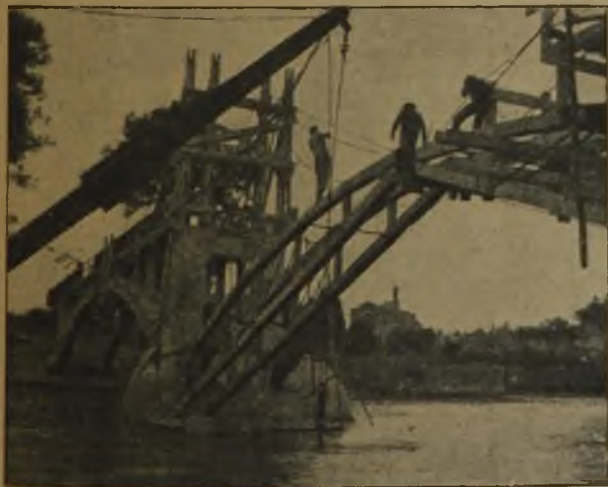
Abbildung 2. Aufstellung des Lehrgerüsts. Im Vordergrund links der Arm eines Greifbaggers zum Ausräumen des Flußbettes.
