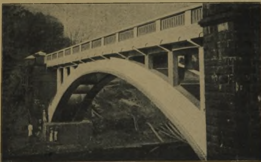
Abbildung 4. Fertige Eisenbeton-Bogenbrücke über den Parappar-Fluß (Indien). Bemerkenswerte Brückenausführungen des Auslandes in Eisenbeton.
