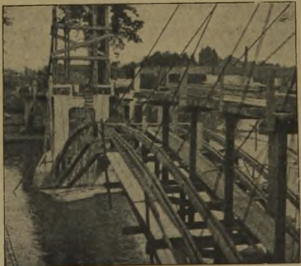
Abbildung 3. Fertiges Lehrgerüst. Wiederherstellung der Eisenbeton-Brücke Vic-sur-Aisne.
