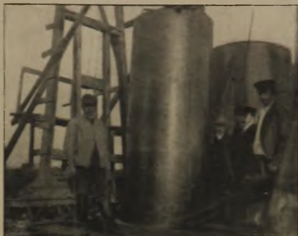
Abbildung 1. Eiserne Rohrformen. Kern mit Paßstück.
