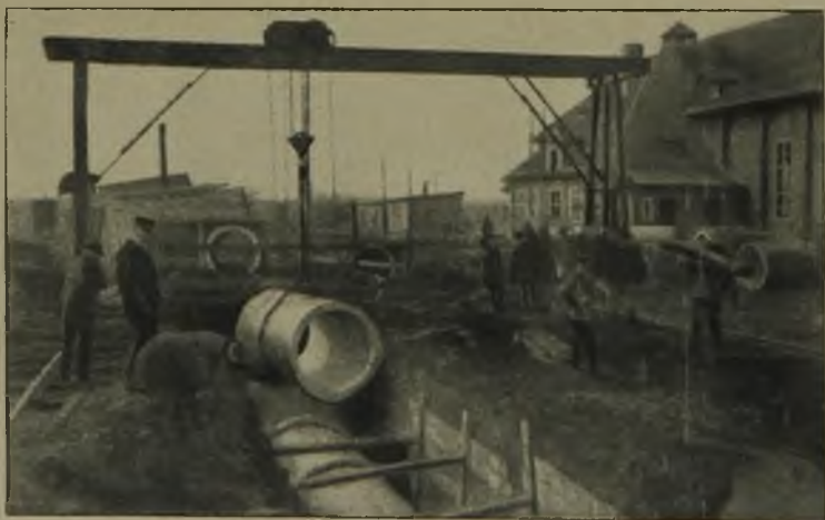
Abbildung 9. Laufkran zum Verlegen der Rohre, Eisenbeton-Druckrohre.
