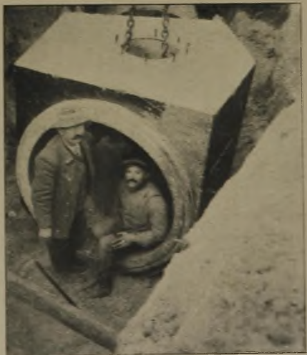
Abbildung 11. Forastücke zur Bildung der Knicke.
