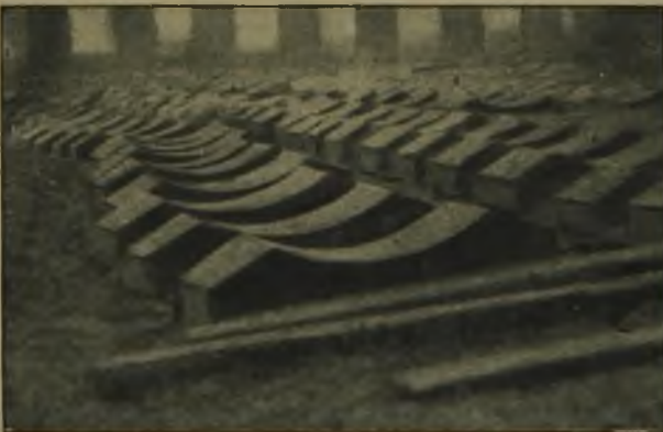
Abbildung 6. Sohlböcke für die Auflagerung der Rohre.
