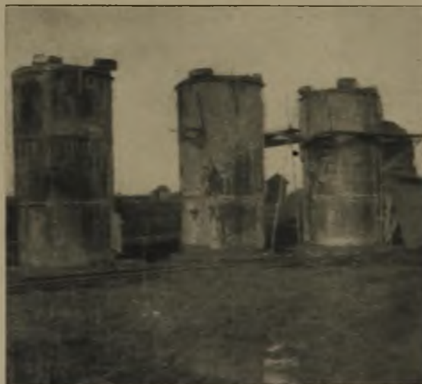
Abb. 3. Rohre in der Form mit oberem Beschwerungsring. Eisenbeton-Druckrohre.
