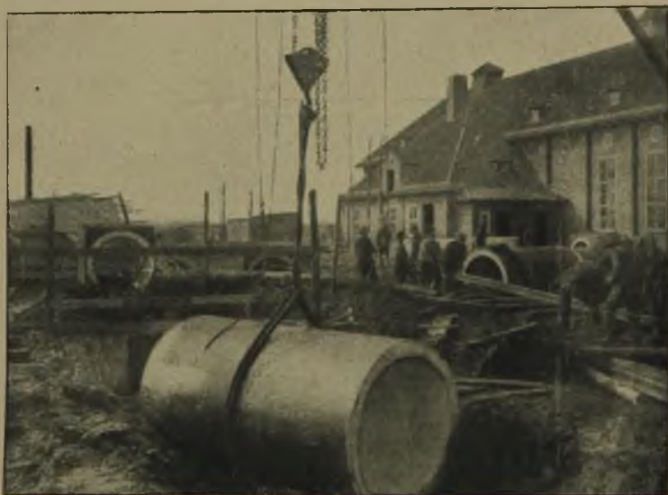
Abbildung 8. Verlegen der Rohre in die Baugrube.
