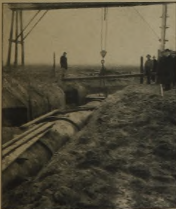
Abbildung 10. Verlegen der Rohre mit Portalkran.
