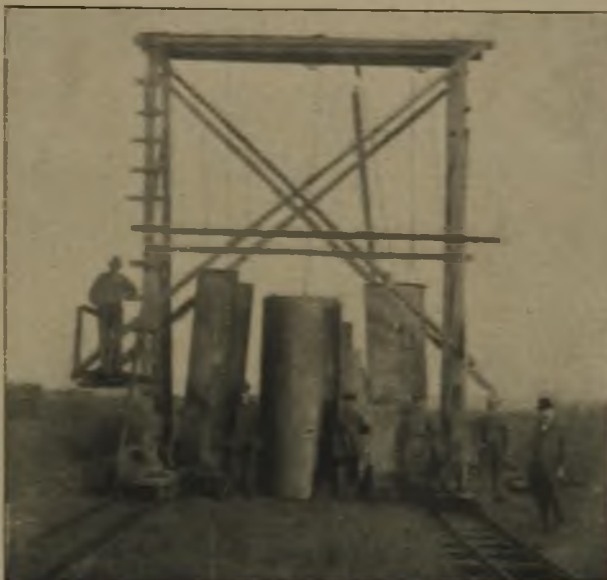
Abbildung 2. Zusammensetzung der Formen mit Kran.
