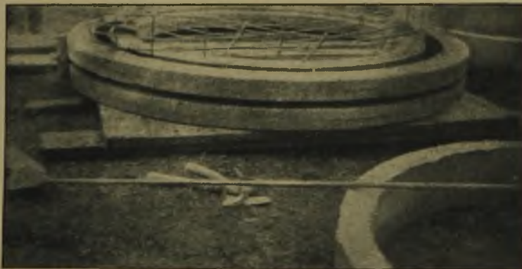
Abbildung 7. Einförmung der Ueberschiebringe der Stöße.
