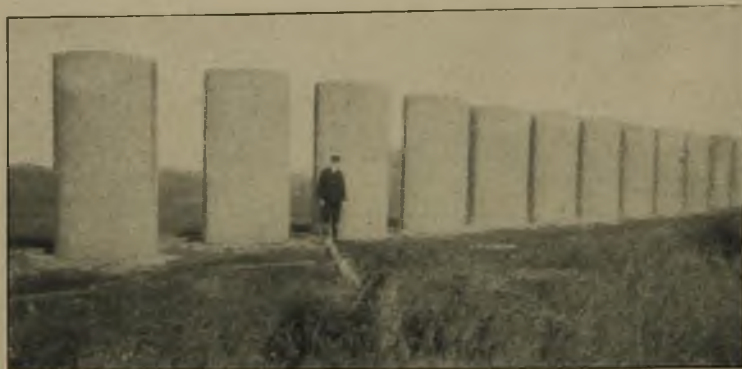
Abbildung 5. Lager fertiger Rohre längs der Baustelle.
