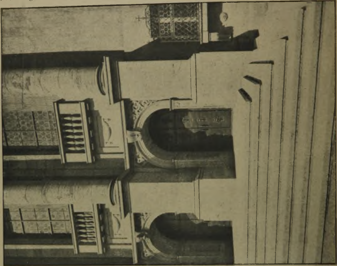
Abbildung 5. Einzelheiten der Hauptfassade. Die Verwendung von Muschelkalkbeton-Werkstein beim Bau der Lutherkirche in Freiburg in Baden.
