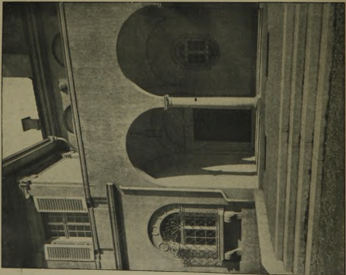
Abbildung 18. Eingang zum Konfirmandensaal. Die Verwendung von Muschelkalkbeton-Werkstein beim Bau der Lutherkirche in Freiburg in Baden.
