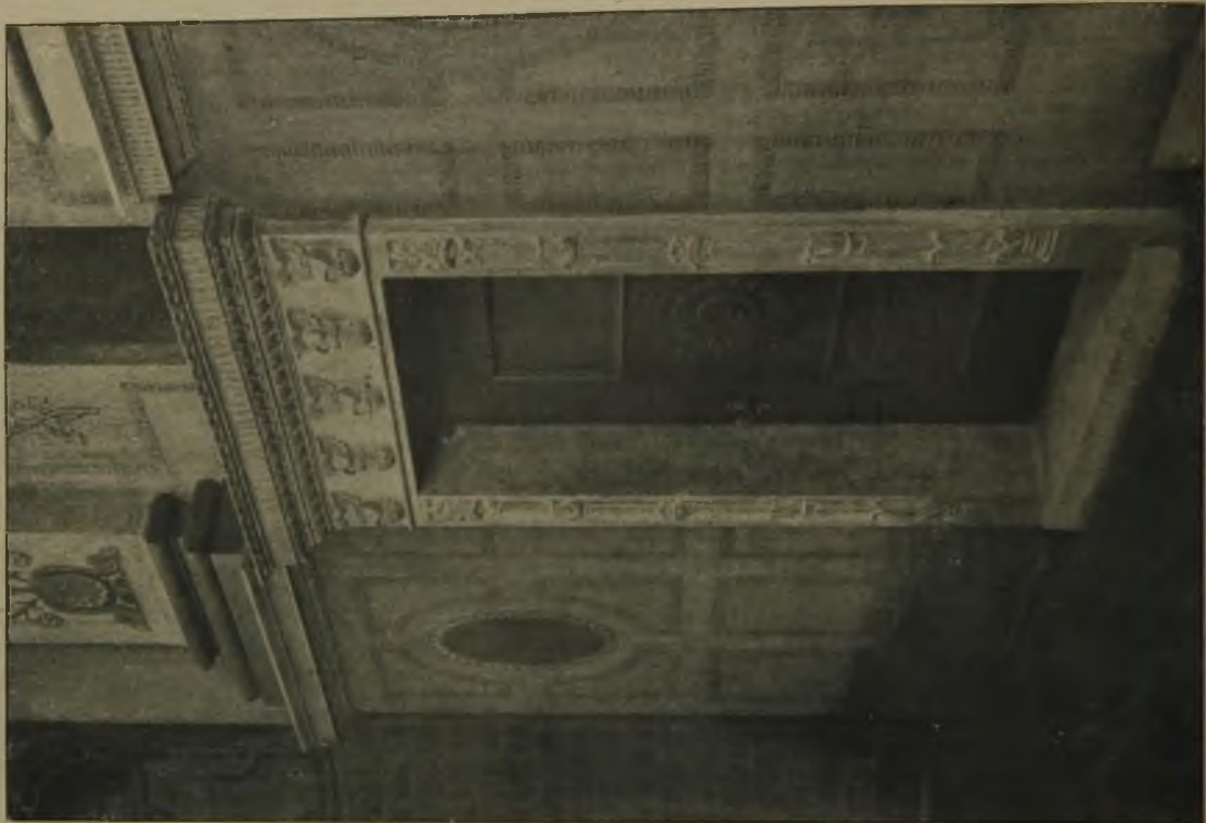
Abbildung 10. Tur unter der Empore. Die Verwendung von Muschelkalkbeton-Werkstein beim Bau der Lutherkirche in Freiburg.
