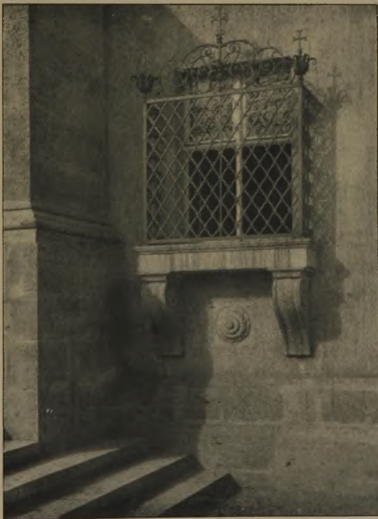
Abbildung 6. Fenster neben dem Haupteingang.
