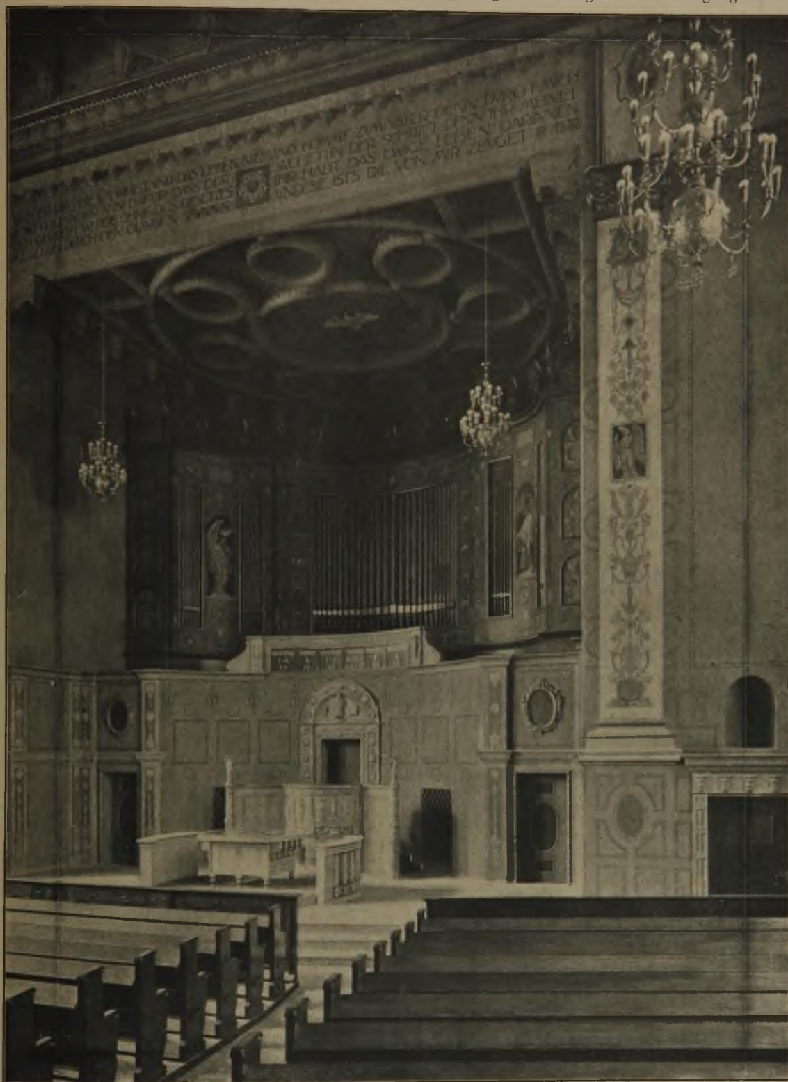
Abbildung 8. Blick in den Chorraum mit Altar, Kanzel und Orgel nebst Orgelempore. Die Verwendung von Muschelkalkbeton-Werkstein beim Bau der Lutherkirche in Freiburg.
