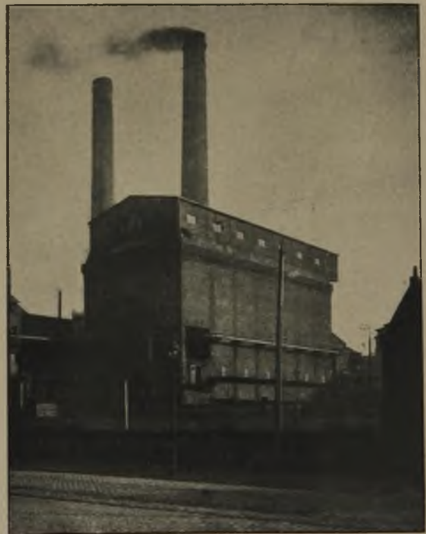
Abbildung 6. Ansicht des fertigen Silos in Duisburg.
