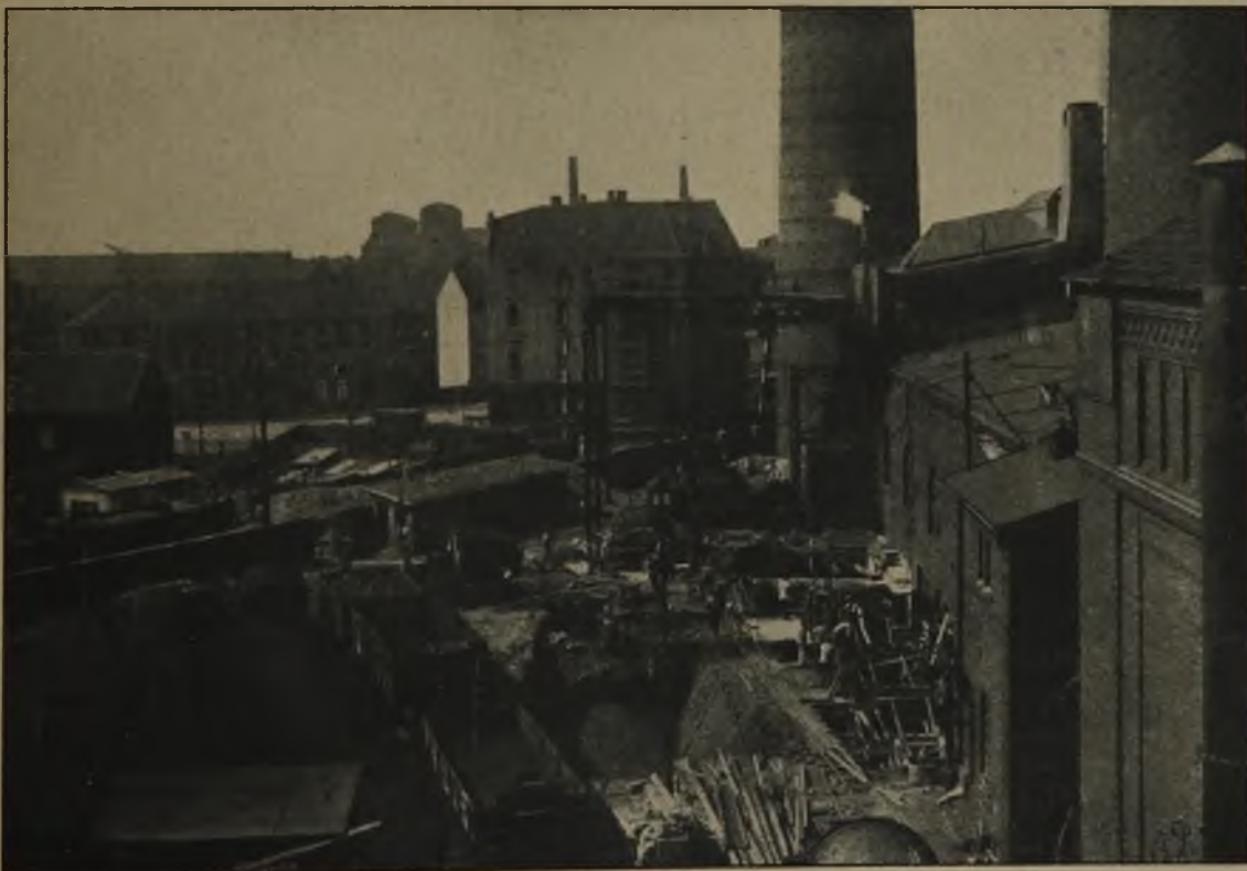
Abbildung 5. Silo Duisburg. Zustand bei Baubeginn. Mitteilungen über ausgeführte Kohlenilos.
