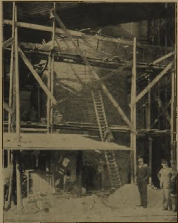
Abbildung 7. Aufbringung der äußeren Spiralbewehrung der Klärtürme der Abbildung 5.
