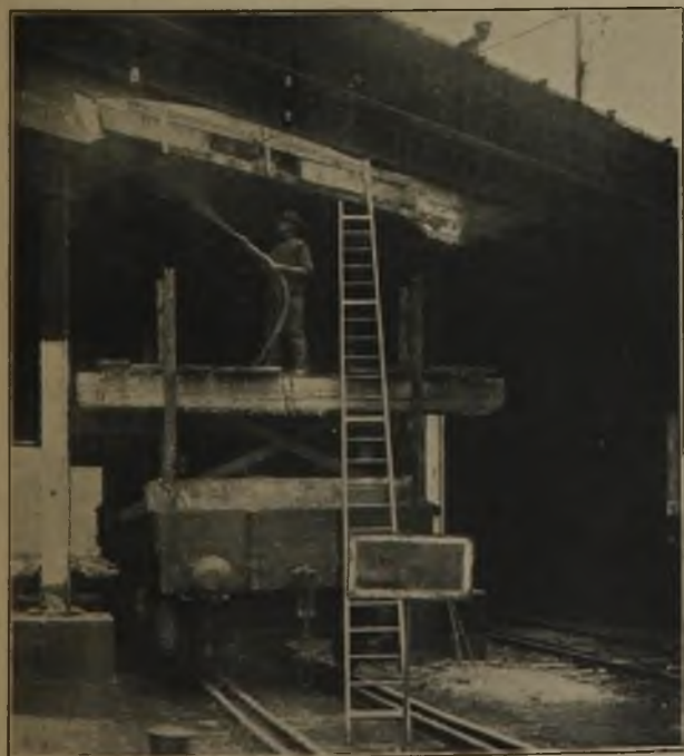
Abbildung 4. Wiederherstellungsarbeiten an einer Straßenbrücke über die Lehrter-Bahn in Berlin.
