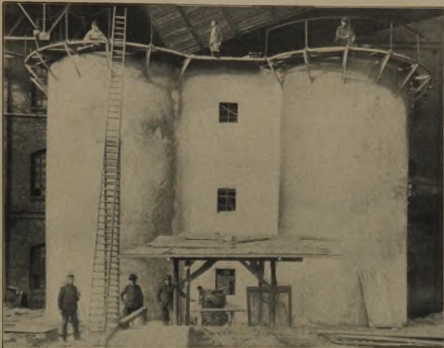
Abbildung 5. Klärtürme für Braunkohlenstaub führende Wässer. Nach dem Torkret-Verfahren umhüllt.
