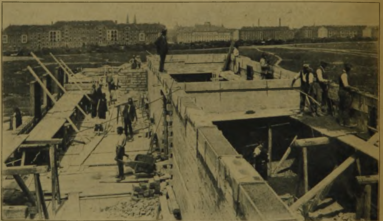
Abbildung 17. Siedlung auf der Schmelz (Wien XV) in Betonhohlblock-Bauweise (Stockwerksgleiche mit Betonrost).
