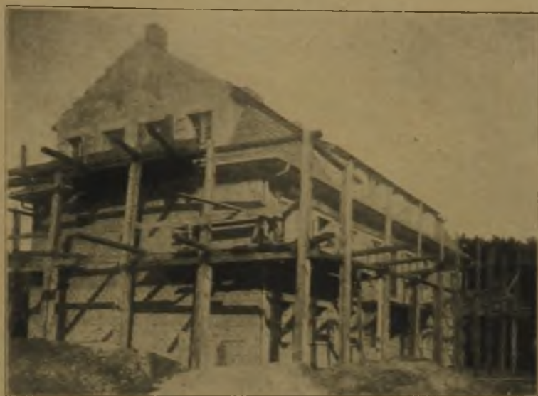
Abbildung 22. Siedelung in Straßhof bei Wien. Bau aus „Pax“-Steinen.
