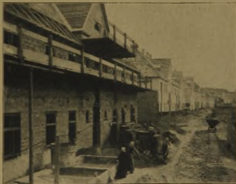
Abb. 20. Siedelung auf der Schmelz in Wien. (Haus im Bau aus Lehmsteinen.)
