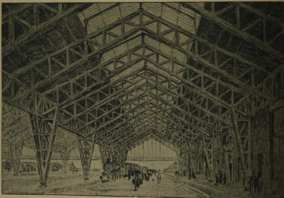
Abbildung 4 und 5. Entwürfe für Hallen von 40 und 20m Spannweite in Holz von Karl Kübler in Göppingen in Verbindung mit Prof. P. Bonatz in Stuttgart.
