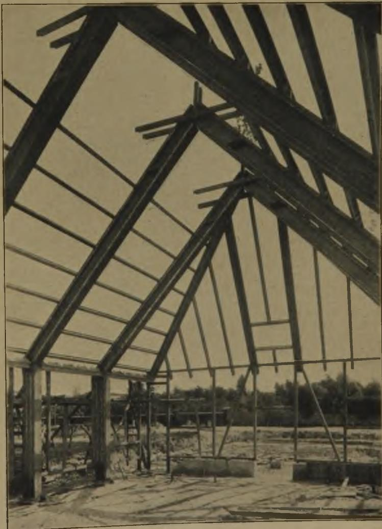
net — im ungünstigsten Belastungsfall 100 kg/qcm Zug oder Druck. Die Schubspannungen betragen 8—12 kg/qcm, die vollauf durch die Nägel aufgenommen werden; letztere sind an den Auflagern enger, in der Mitte der Riegel und Pfetten und am oberen Ende der Ständer weiter verteilt, und zwar sind die Abstände nach der bekannten Kreisteil-Methode der Zerlegung eines Dreiecks in Flächen gleichen Inhaltes derart bestimmt, daß jeder Nagel gleich viel Schubkraft aufzunehmen in der Lage ist.
