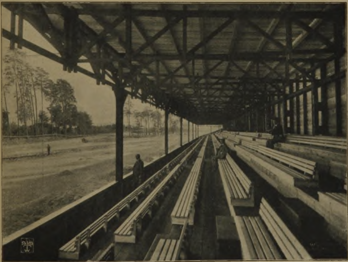
Abbildung 3. Innenansicht der Tribüne H an der neuen Automobil-Rennstraße in Berlin-Nikolassee.
