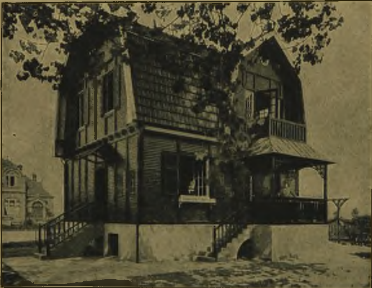
Abbildung 1 und 2. Verwalterhaus für das Evangelische Krankenhaus in Köln-Lindenthal.
