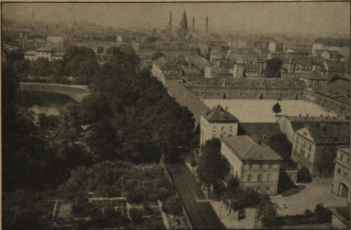
Blick vom Turm des Fernheizwerkes auf das Marstall-Gebäude in Dresden.
