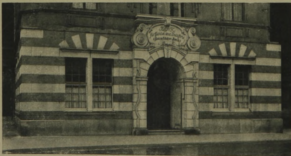
Ausgeführter Umbau des Erdgeschosses der „Glocke“. Architekt: Stadtbaurat Hans Strobel.
