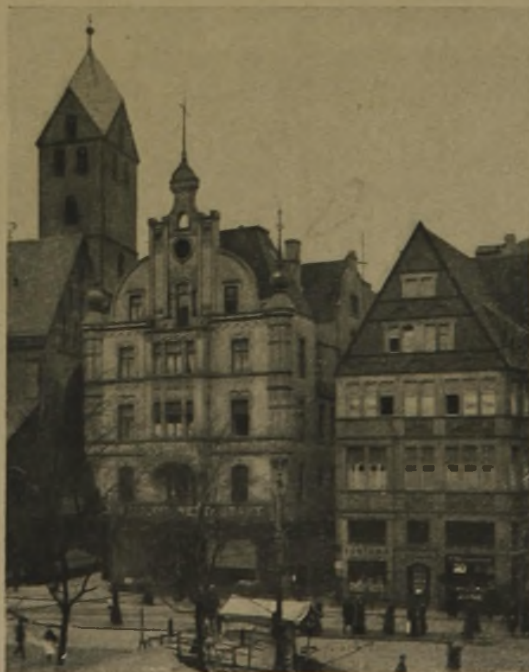
„Die Glocke“ am Osten-Hellweg No. 3 in Dortmund. Alter Zustand.
