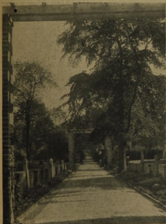
Blick durch die verbindenden Pergolen auf dem Ehrenfriedhof. Seitlich eingemauerte alte Grabsteine.
