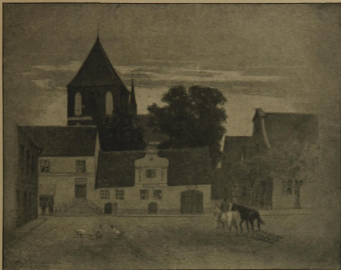
Ansicht aus Tolkemit nordöstlich von Elbing. Aufnahme von Geh. Ob.-Brt. Art. Kieckton in Potsdam.
