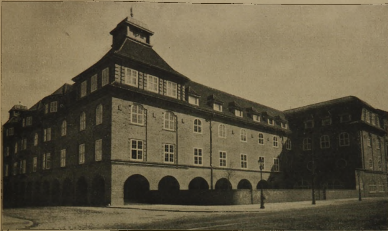
Ansicht von Ecke Bollwerk und vom Turnhof.
