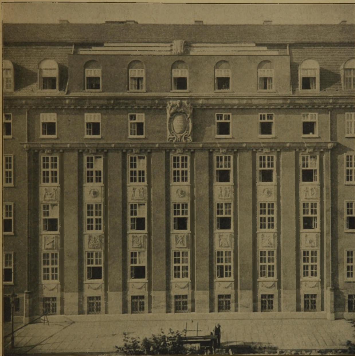
Ansicht des Mittelbaues an der Dürer-Straße.
