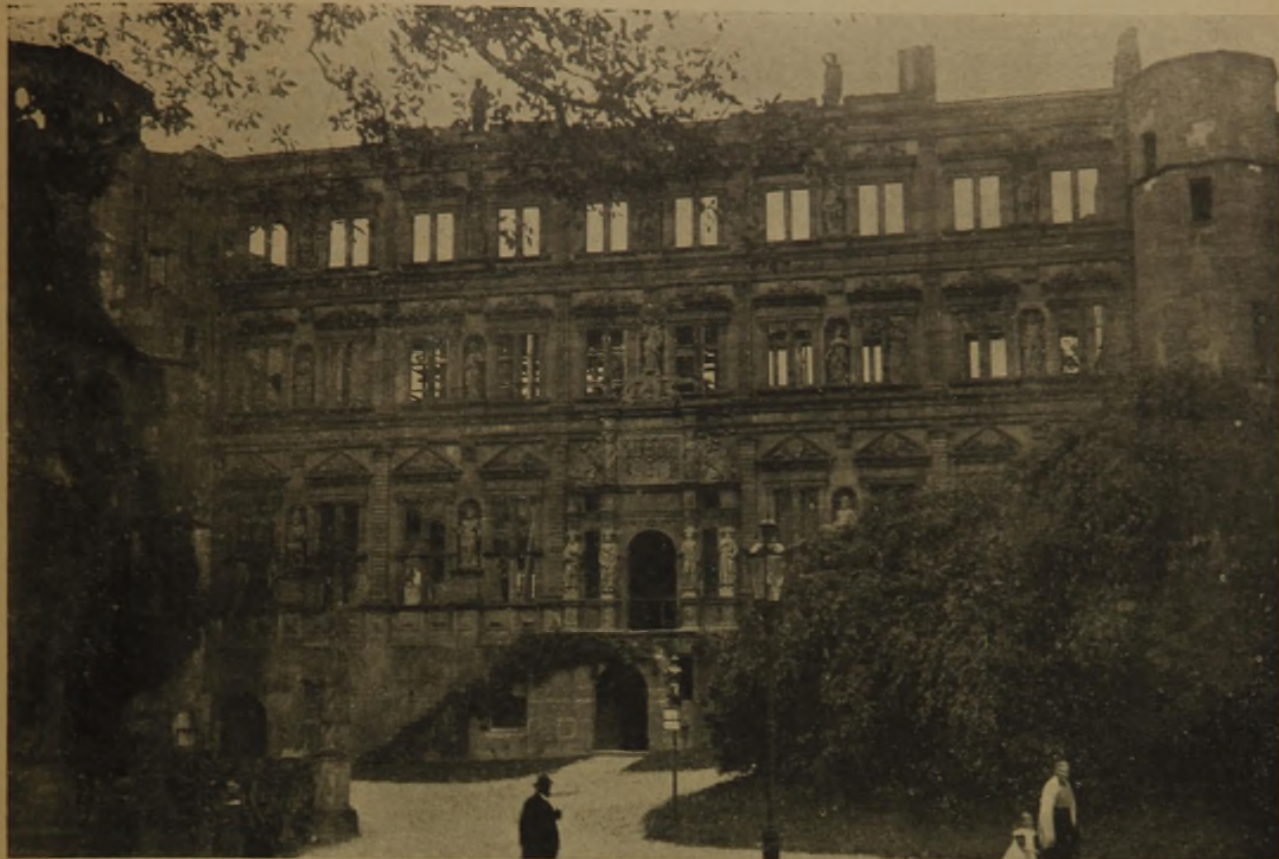
Der Verfall des Heidelberger Schlosses: Der Otto Heinrichsbau, an dem kürzlich, wie auch an den übrigen Teilen des Schlosses, durch Untersuchungen bedeutende Mängel festgestellt wurden, welche die völlige Zerstörung dieses Prachtwerkes der deutschen Renaissance in absehbarer Zeit befürchten lassen.
