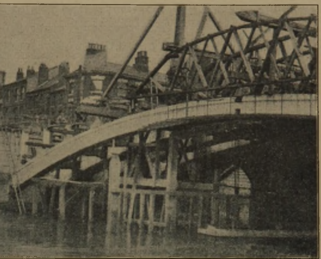
Abbildung 4. Ausführung der Bogenrippen.
