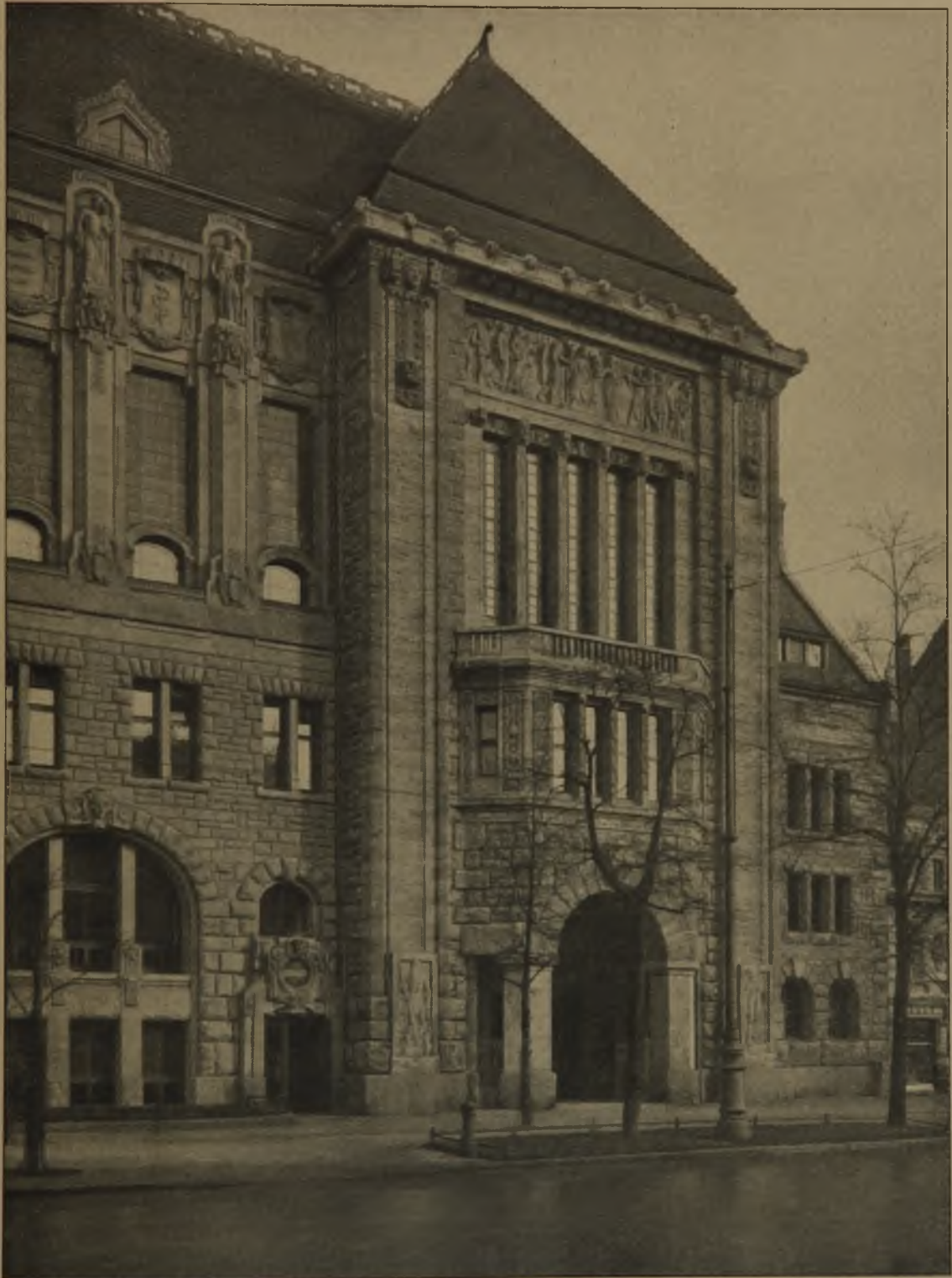
Östliches Risalit mit Eingang zur Sparkasse.
