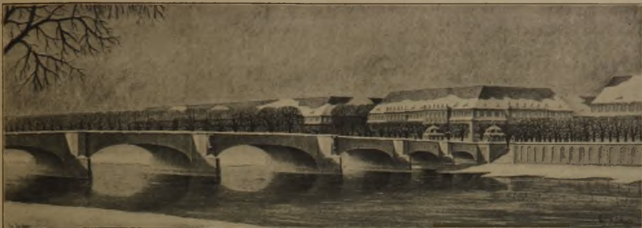
Ansicht der Brücke mit Blick auf die Altstädter Seite.
