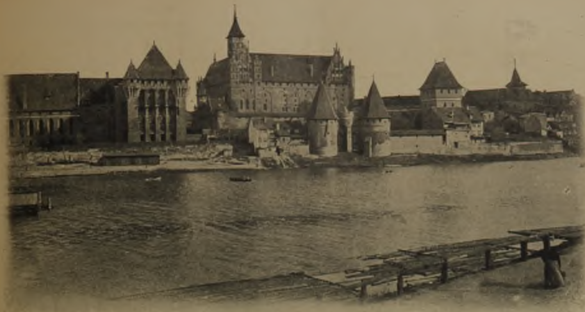
Die Baugruppe der Marienburg. Ansicht von der Nogat.
