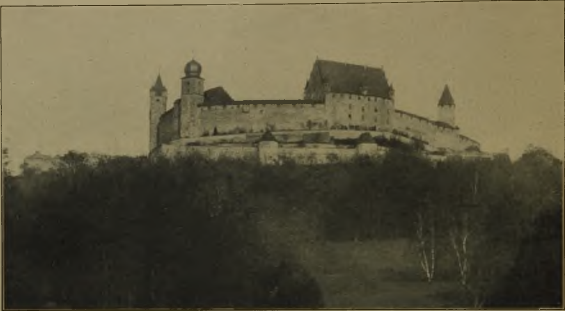
Ansicht der Veste Coburg von der Südseite nach dem Wiederaufbau.
