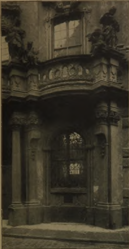
Teil des Portales der Universität in Breslau.
