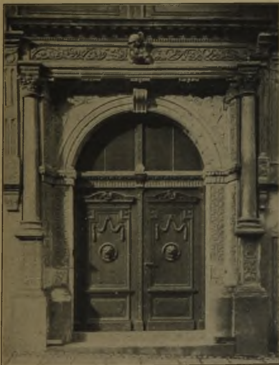
Portal eines Patrizierhauses in Görlitz.
