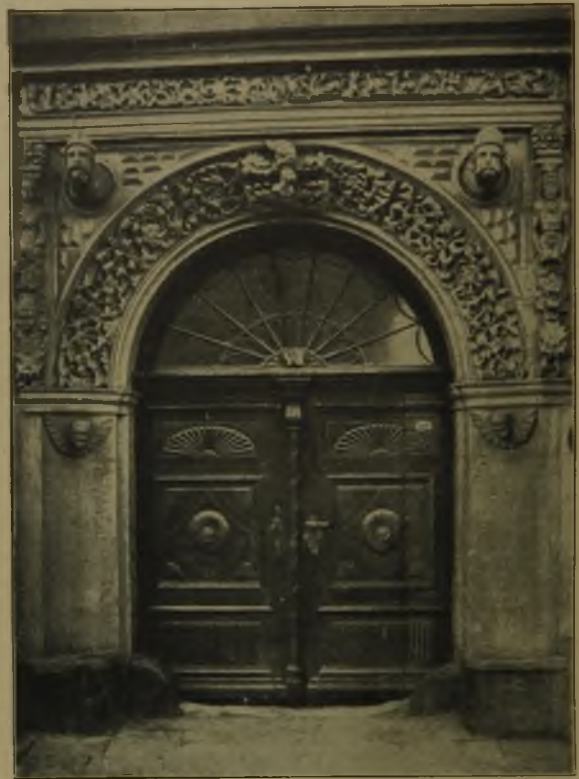
Sandstein-Portaleines Hauses in Bunzlau.
