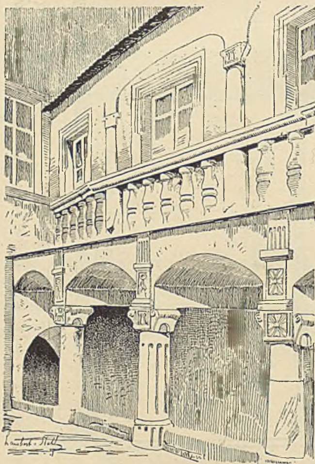
Rys. 123. Podcień ze Lwowa (Löwenberg) na Szląsku o słupach z głowicami, które składają się z kwadratu i dwóch wsporników. (Z dzieła: Schlesische Kunstdenkmäler.)
