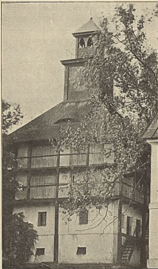
Wiz. 118. Przykład podcieni przez dwa piętra sięgających, przyczem słupy środkowe i boczne założone są znamienne na prawie połowienia dwukrotnego. — U góry wieżyczka na prawie połowienia pojedynczego.
