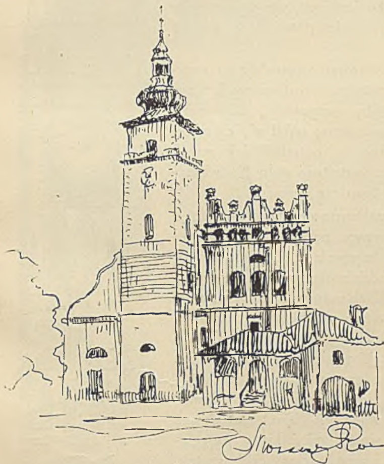
Rys. 160. Ratusz w Podolińcu na Spiżu. — Ściana czołowa na prawie połowienia „dwukrotnego”, ponieważ ma pięć węzłów działowych a cztery pola.
