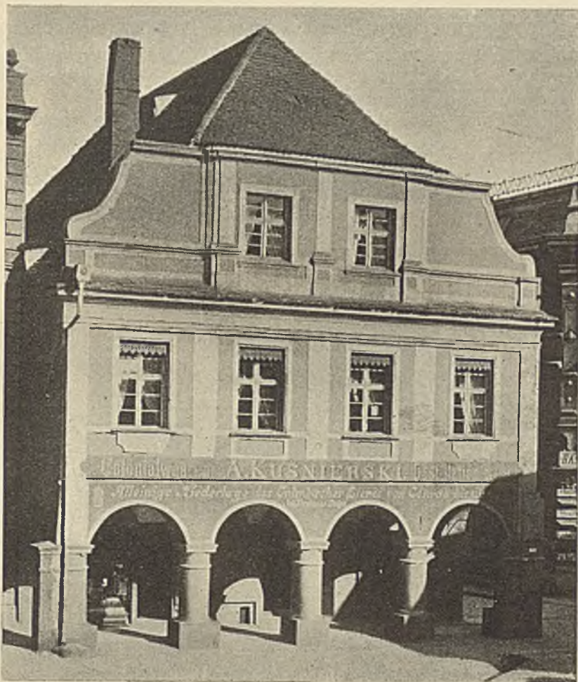
Wiz. 138. Podcień z rynku miasta Leszna o pięciu słupach, ze słupem na osi głównej, z czego wynika linja działowa przez piętra także w osi głównej.
