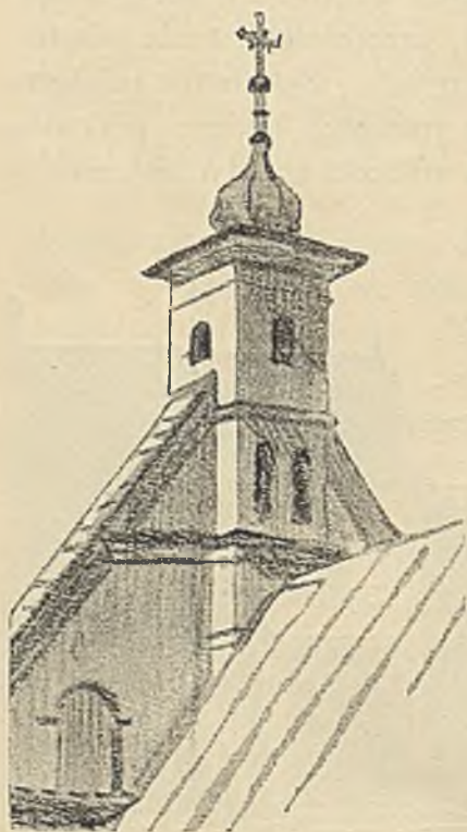
Rys. 192. Sygnaturka wieńcząca do niedawna szczyt kościoła parafjalnego w Krośnie, zburzona przed kilkoma laty; a na jej miejscu postawiono nową nieodpowiednią.
