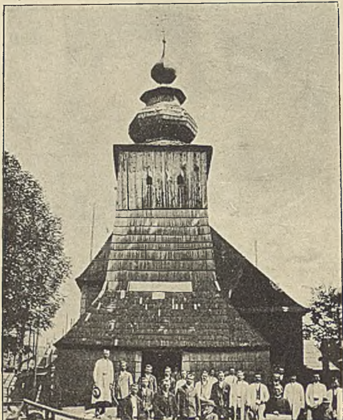
Wiz. 188. Widok kościółka modrzewiowego w Cieklinie (koło Jasła) z wieżą na przedzie, ze zwieńczeniem kopulastem w taki sposób przeprowadzonym, że krawędzie ośmioboku spadają na osie główne i przekątne. (Zabytek zburzony).
