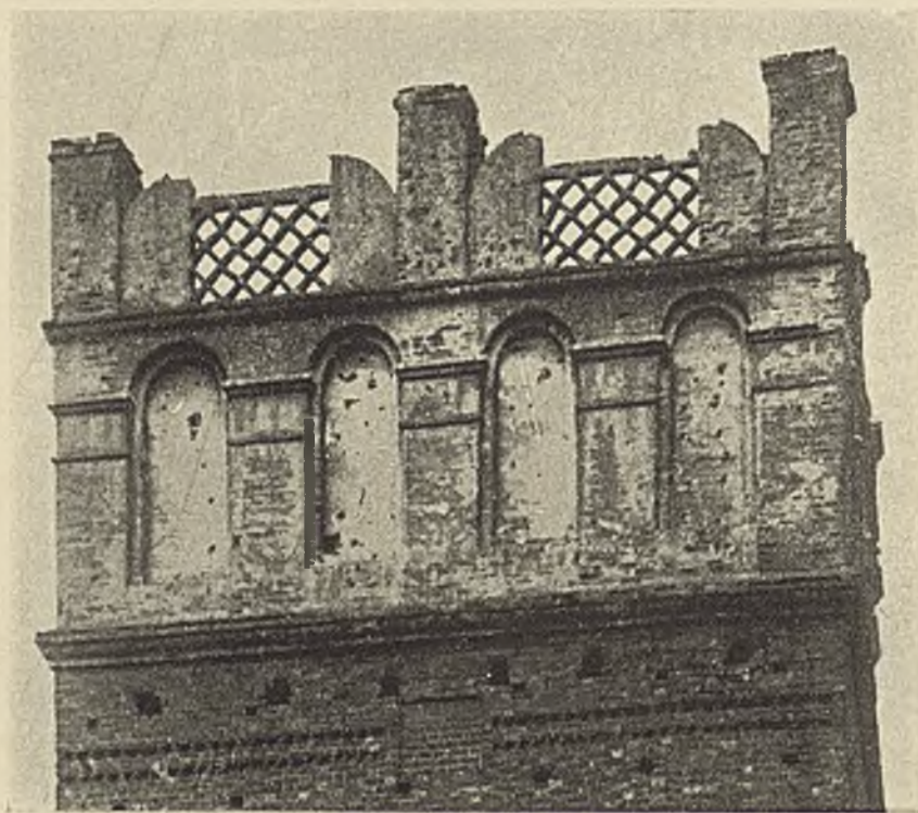
Wiz. 171. Szczegół ściany czołowej czyli attyki bramy Opatowskiej ze Sandomierza. We wnękach prawo połowienia „dwukrotne“ t. zn: pięć węzłów działowych i cztery pola. (Gdzie dziś krata musiały być ślimaki i słupki w osiach nad pilastrami).
