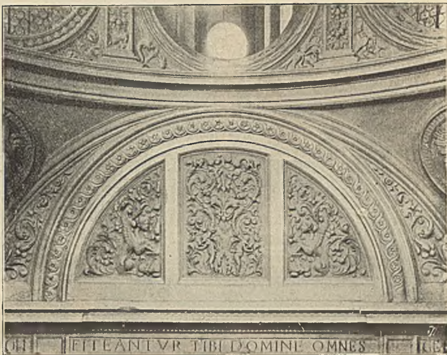
Wiz. 184. Szczegół pola pod łękami przy żagielkach dla przejścia z kwadratu w koło (Kaplica Zygmuntowska).
