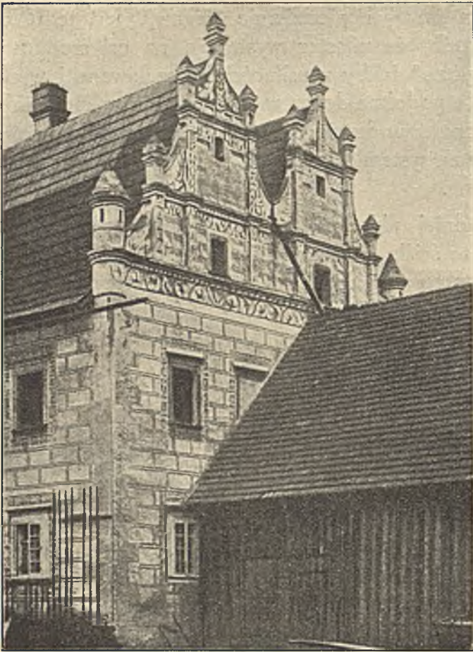
Rys. 81. Wystawa boczna z zamku w Ratzynie na Szląsku. Zasada połowienia dwoma szczytami oznaczona. (Wedle dzieła: „Alt-Schlesien“).
