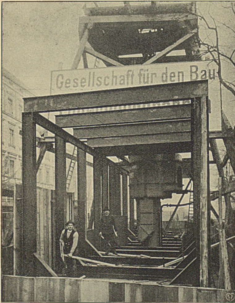
Abbildung 41. Fundirung der Untergrundbahn am Potsdamer Platz.
