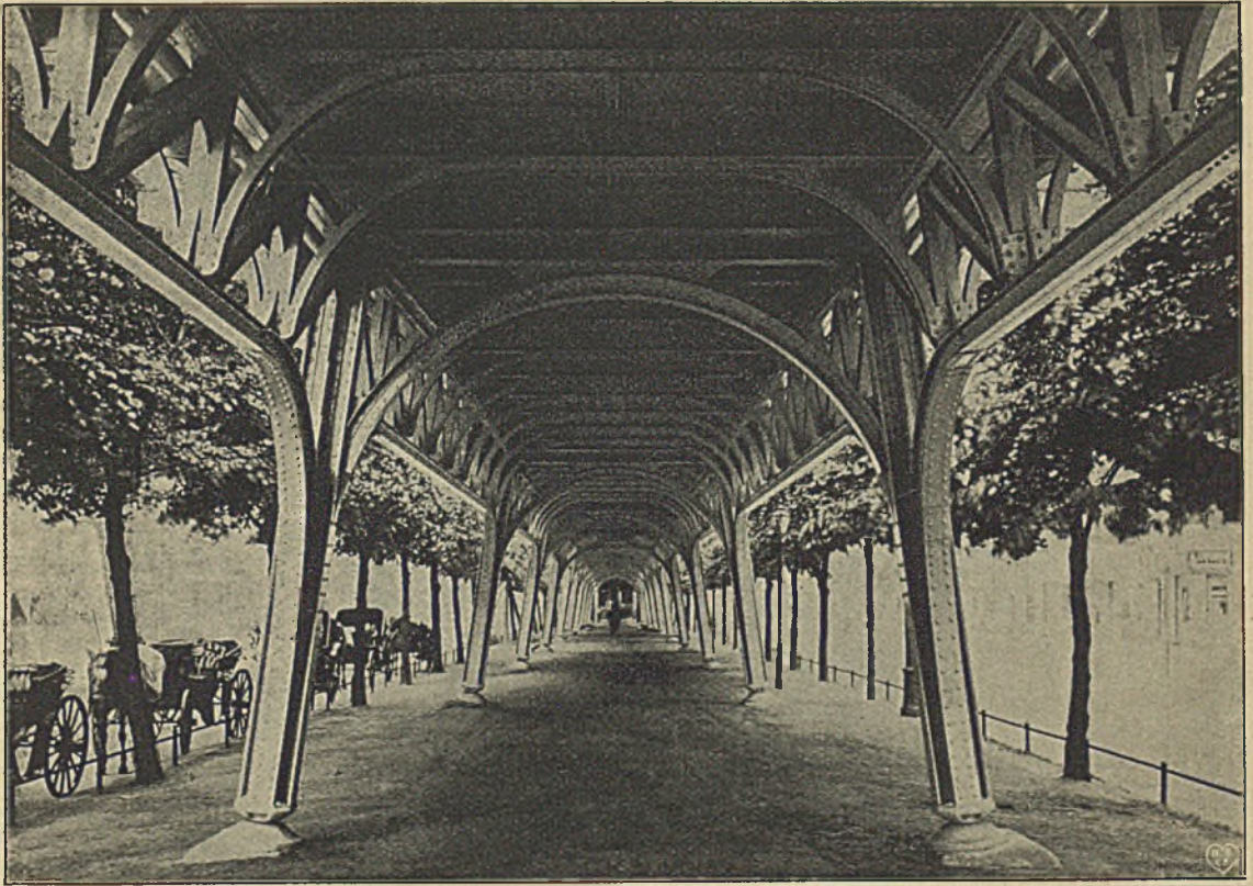
Abbildung 16. Mittlerer Gehweg in der Bülowstraße mit der elektrischen Hochbahn.
