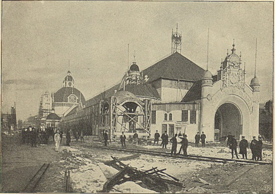
Abbildung 8. Blick auf die Haupt-Industriehalle, Eingang zu Gruppe Hüttenwesen.
