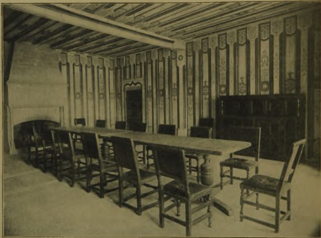
Speisesaal im Fürstenbau mit alter Bohlen-Vertäfelung und alter, ergänzter Malerei.
