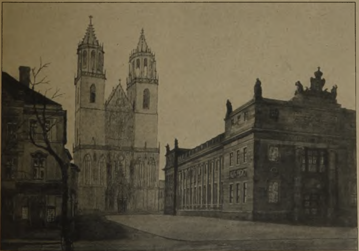
Verbreiterte Dom-Strasse in Magdeburg mit einem Neubau der Reichsbank.
