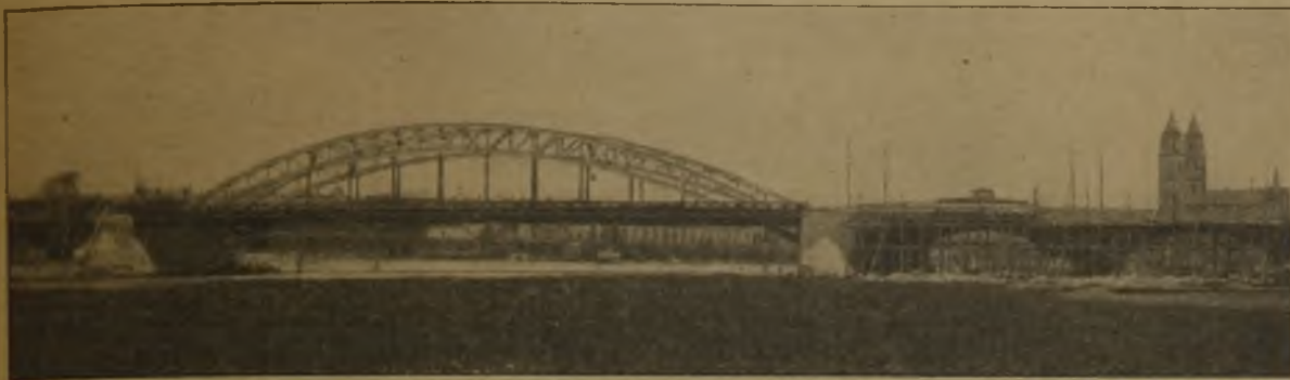
Die neue Störnbrücke über die Elbe in Magdeburg.
