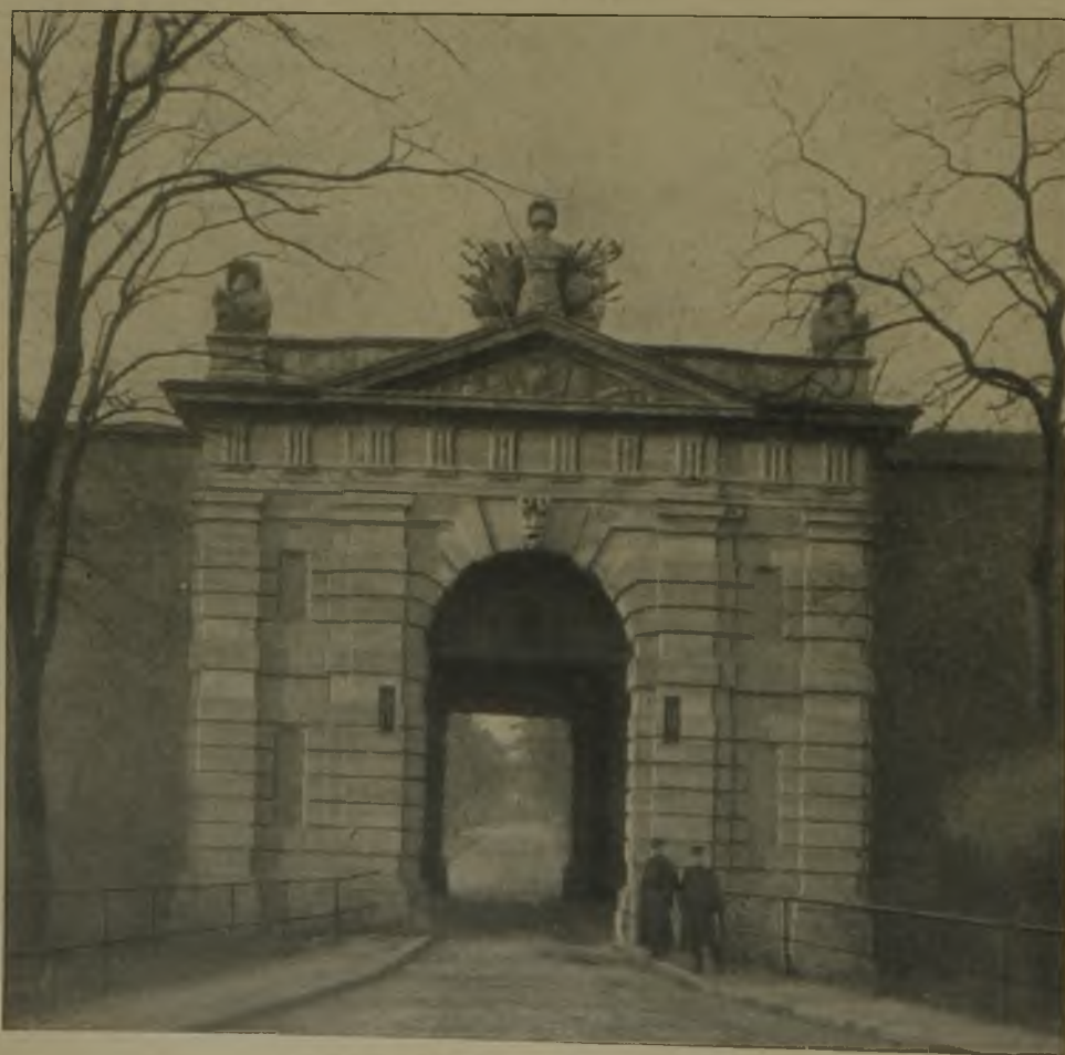
Außenansicht des Wassertores C.
