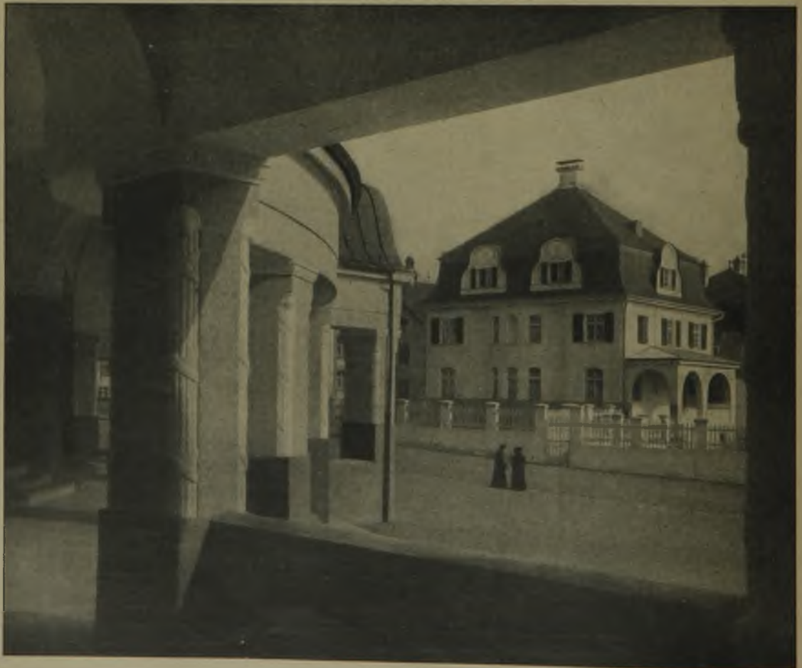
Ansicht des Pfarrhauses von der Vorhalle aus. Die neue Kirche Peter und Paul in Lindenberg im Allgäu. Architekt: Professor Franz Rank in München.
