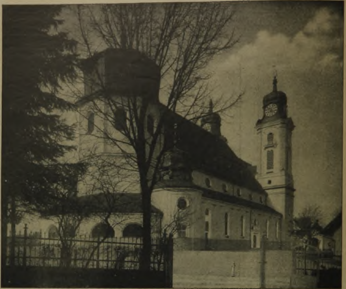
Gesamtansicht vom Chor.
