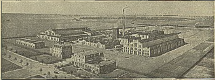
Abbildung 1. Gesamtanlage der Maschinenfabrik Louis Soest & Co., G. m. b. H., Düsseldorf-Reisholz.
