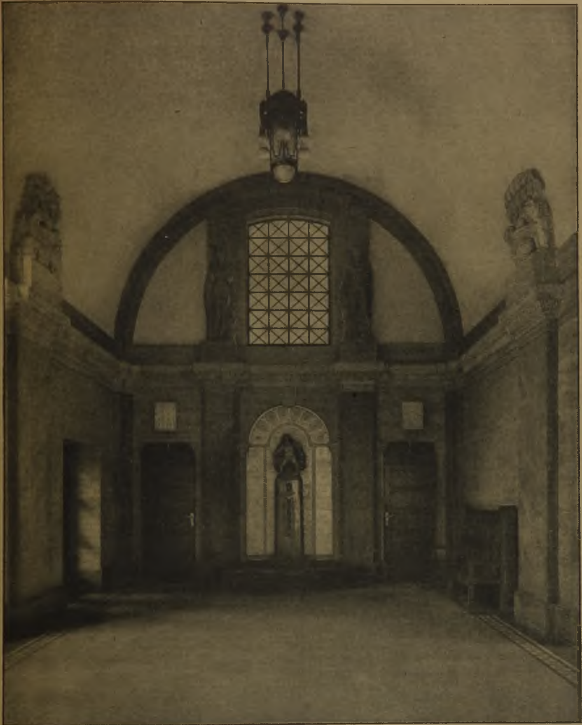
Verbindungshalle zu den älteren Bauteilen des Rathauses von der großen Sparkassenhalle (rechtsseitige Querwand mit Brunnen und den Zugängen zu den Toiletten; siehe auch Schnitte A und B I).
