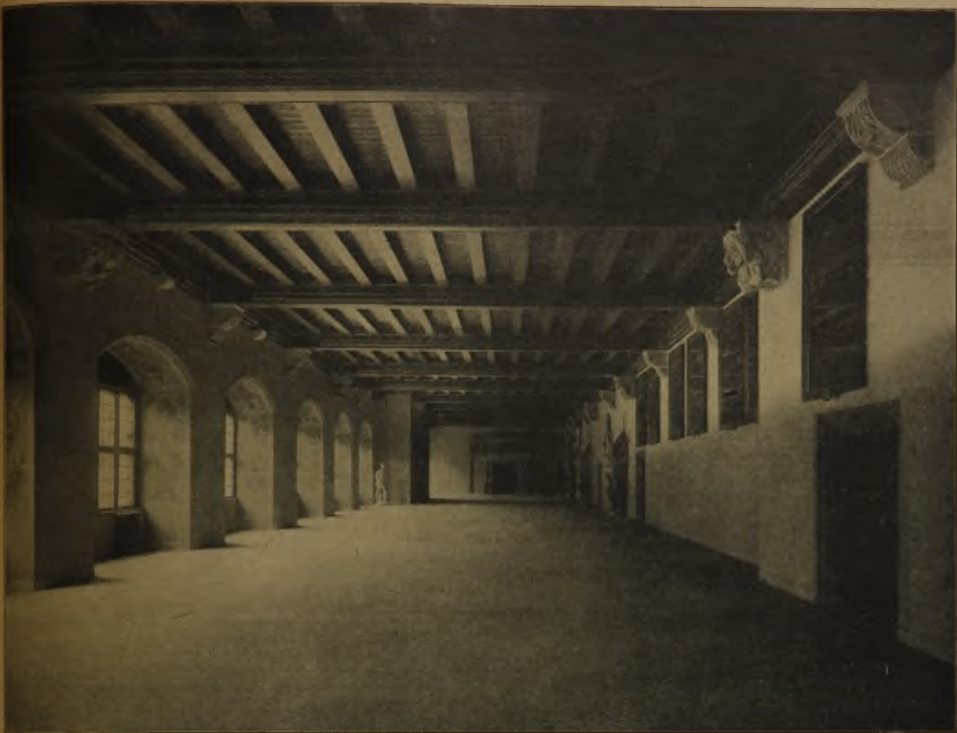
Aus der Baugeschichte des Alten Rathauses in Leipzig. Großer Saal nach Norden nach dem Umbau.
