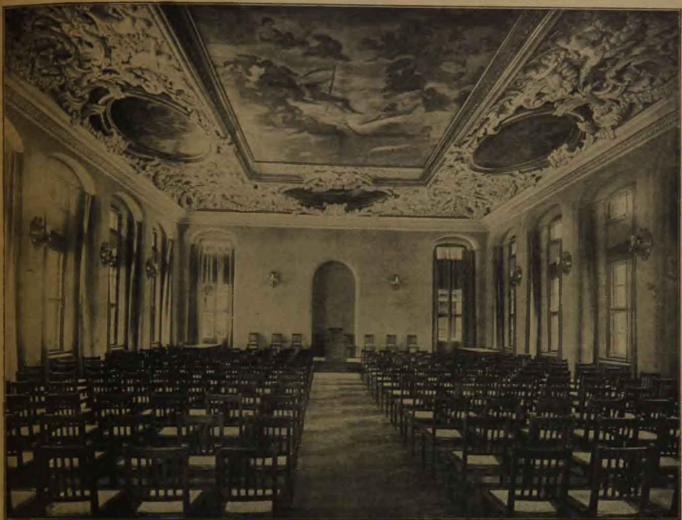
Der Umbau der Alten Börse in Leipzig. Vortragssaal nach dem Umbau.
