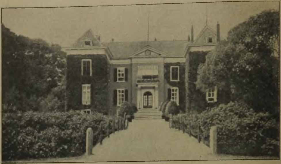
Haus Doorn nach dem Umbau. Mit neuer Freitreppe und neuem Balkon.
