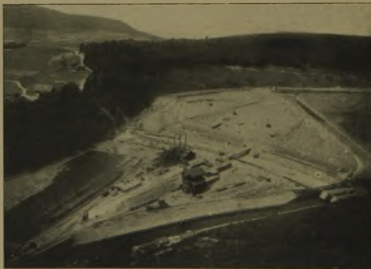
Abb. 6. Baustelle der Waldecker Talsperre.
