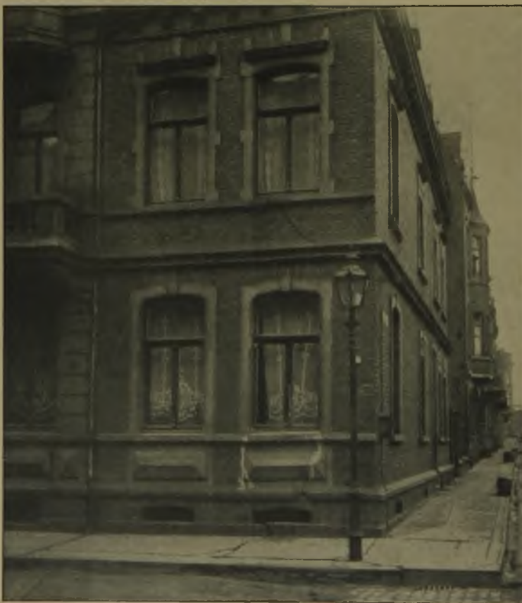
Abb. 3 (oben) — 5 (unten). Rißbildungen infolge Absinkens nach einer links bezw. rechts gelegenen Senkungsmulde.
